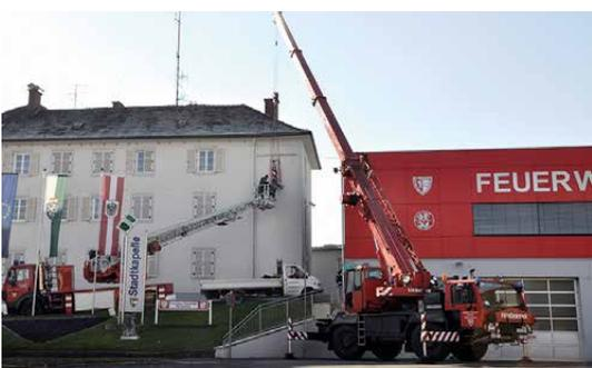
2009 wurde die sehr stark beschädigte, etwa 600 kg schwere Steinfigur abgebaut, restauriert und die Originalfassung (Schutzbemalung) anhand von Überresten wieder hergestellt.
